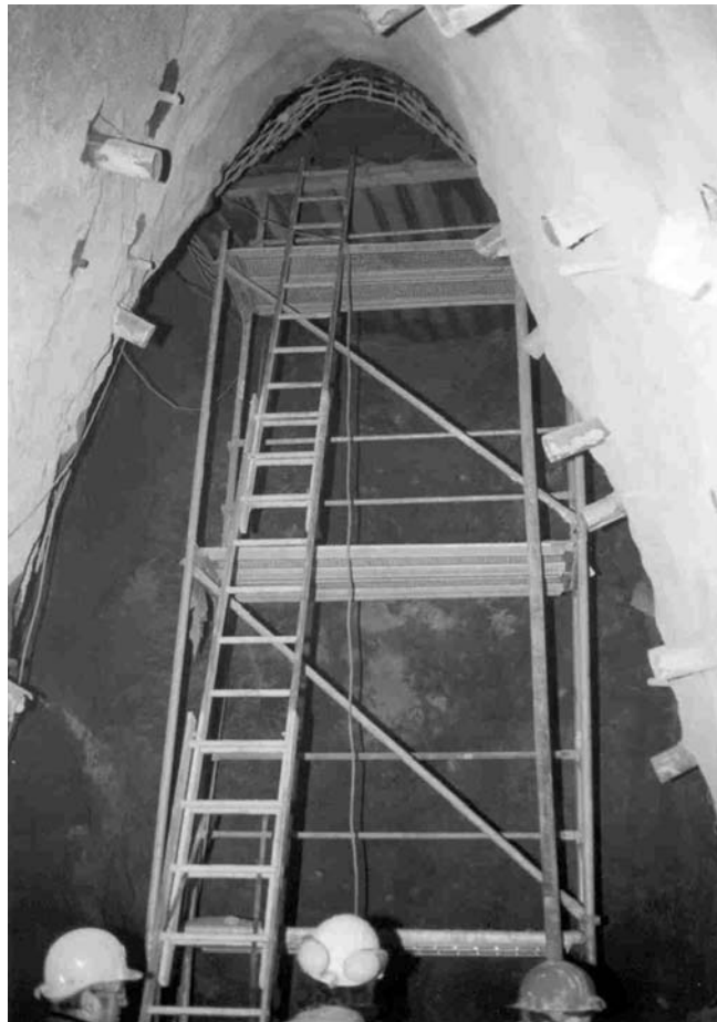
Abb.7 : Dom mit Entwässerungsrohren
